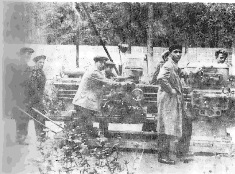
Muncitori și tehnicieni lucrând la montarea primelor utilaje
